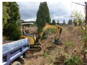
復元作業中の現場
